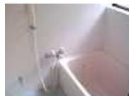
厚さ3mmの発泡樹脂に塩ビフィルムを貼ったパネルで天井や壁面を覆います。また発泡樹脂の効果で保温効率も上がります。壁面のタイルがひび割れている・目地がカビで汚れているなどの場合に最適です
